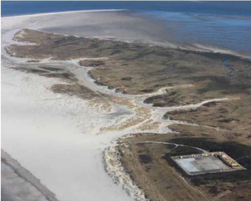
Ameland, gaswinstation Ameland-Oost-1 van de NAM op de oostpunt van Ameland met daarachter natuurgebied De Hon. Samen met twee boorplatforms in de Noordzee wordt hier circa 700 miljoen kubieke meter aardgas per jaar geproduceerd. Dit is ruim voldoende om alle huishoudens in de provincie Friesland van aardgas te voorzien 15 april 2010
