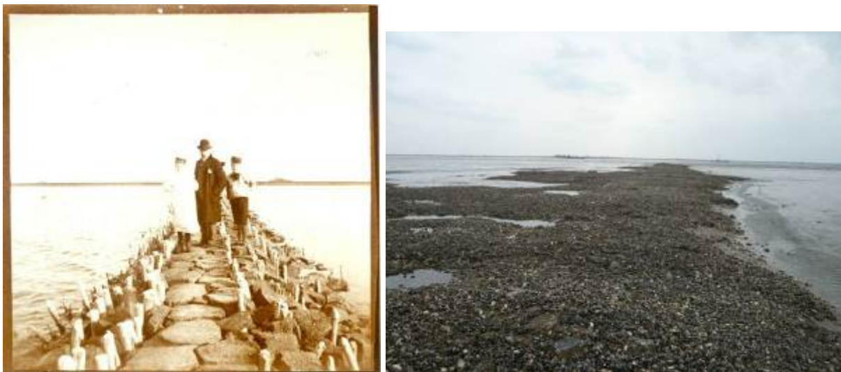
Afbeelding 26: Links een foto van de dam naar Ameland na de voltooiing in 1872. Op de dam de bedenker van de dam dhr. Teding van Berkhout (bron: internet). Rechts: een recente foto van restanten van de dam.
