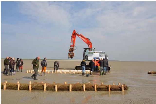
Aanleg van mosselkratten bij de Feugelpôle
