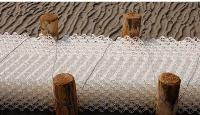
De kratten worden met ijzerdraad vastgemaakt.
